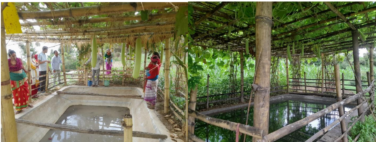
दुल्लू स्थित नौलाघारमा निर्माण गरिएको सोएल सिमेन्ट ट्यांक तथा त्यसमा गरिएको लौका खेति
